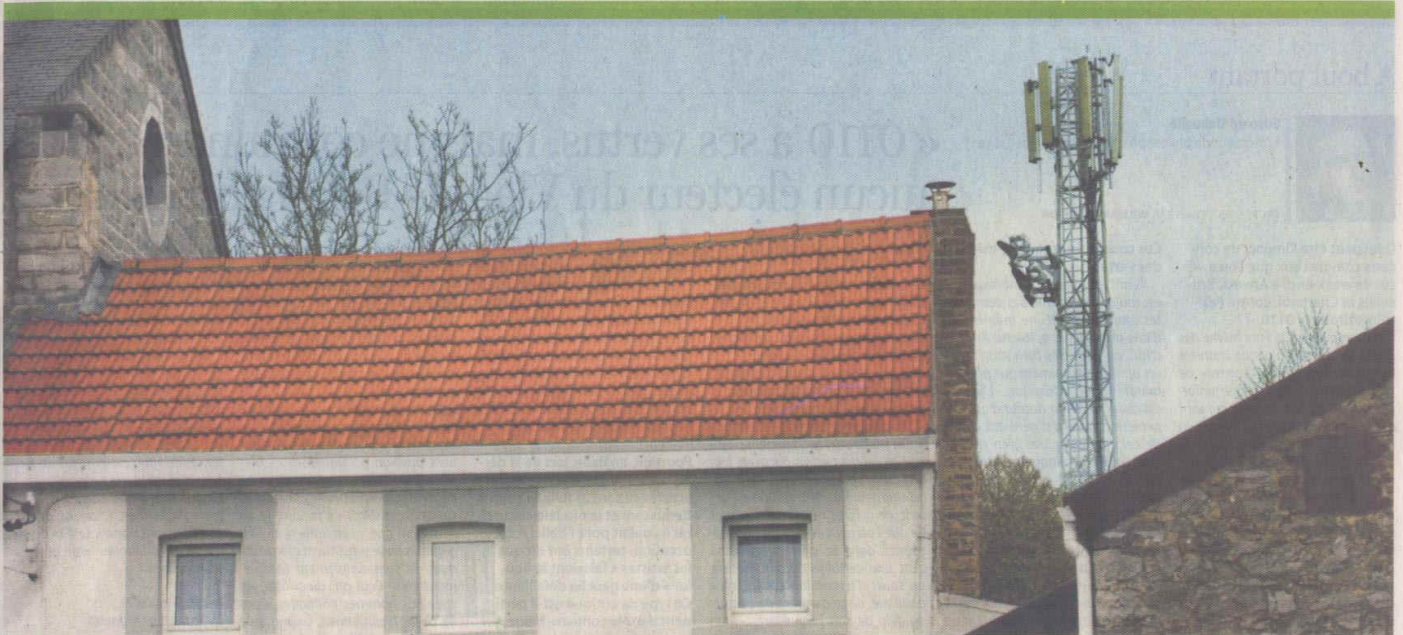
LES NORMES BELGES d'exposition (20,6 volts par mètre) sont insuffisantes, estime la communauté scientifique, même si 80 % des antennes ne dépassent pas 3 V/m dans les faits. PHOTO: R. MILUTIN.
